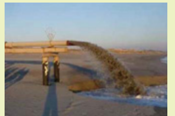
太田川の護岸整備、浚渫(しゅんせつ)、浅羽海岸・福田漁港サンドバイパスの早期復旧工事への取組
